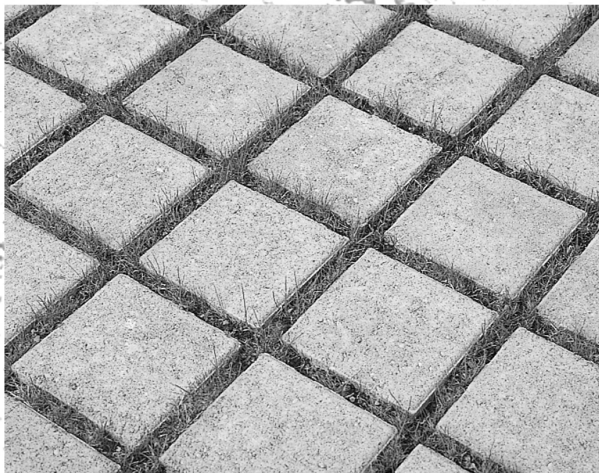
Pavage perméable à l'eau avec joints engazonnés.
