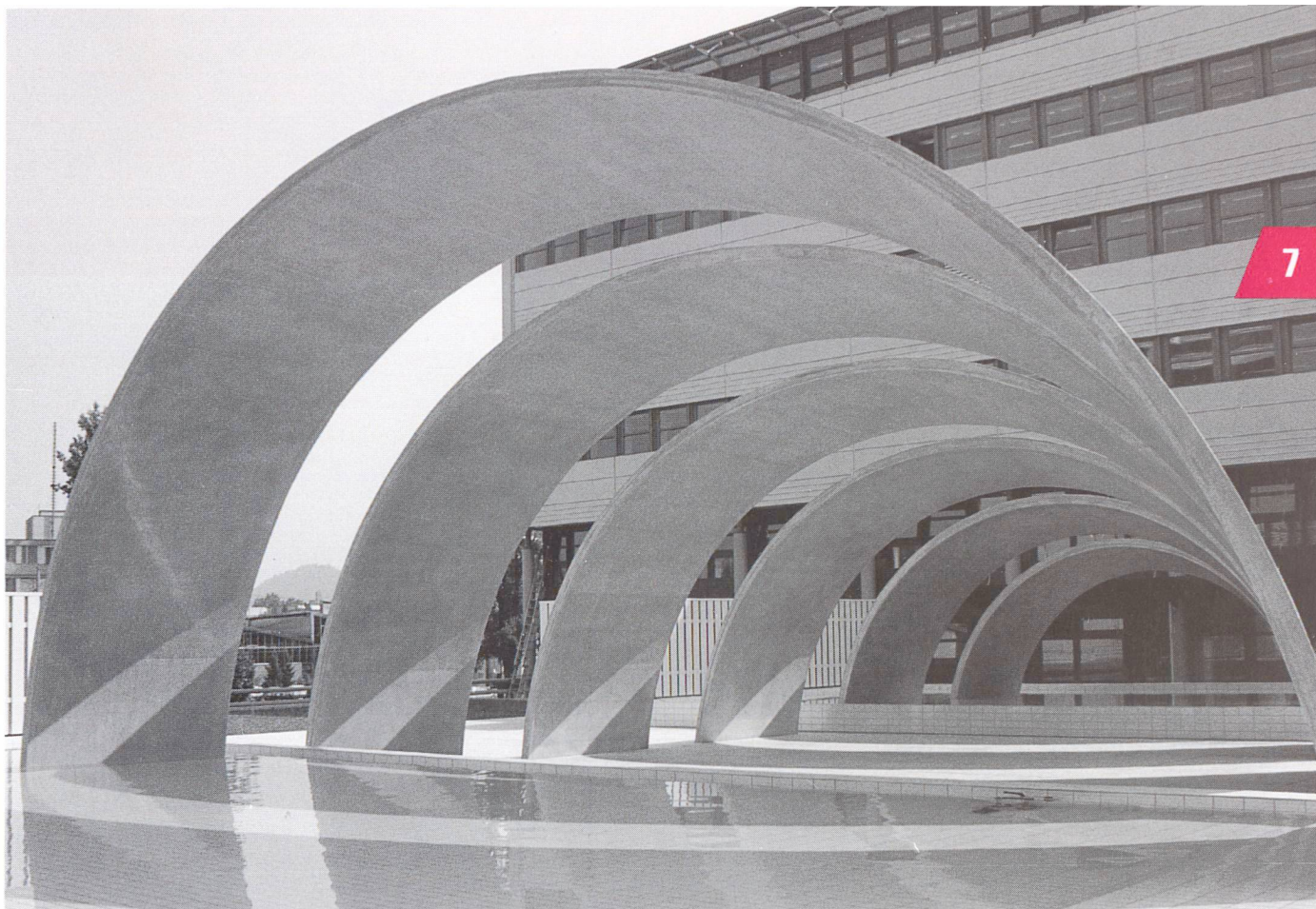
L'épaisseur de chacun des arcs de l'œuvre plastique située devant le bâtiment administratif de la direction des télécommunications de Lucerne n'est que de 13 cm.
