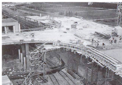
Un important domaine d'utilisation du béton retardé: les grandes surfaces telles que dalles de pont.
