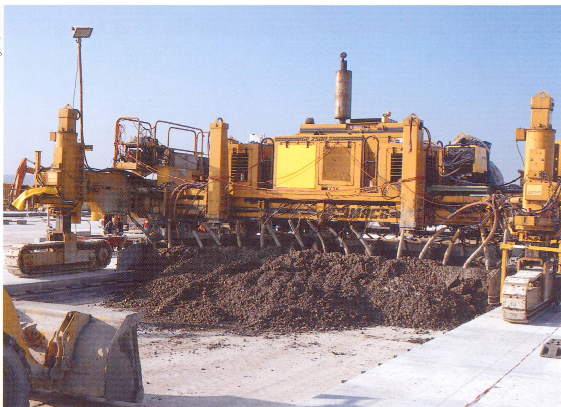
Mise en place avec finisseuse sur rails.
