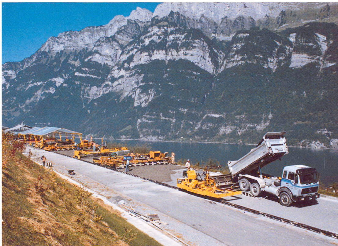
Train de bétonnage sur rails sur l'autoroute du Walensee (N3).
