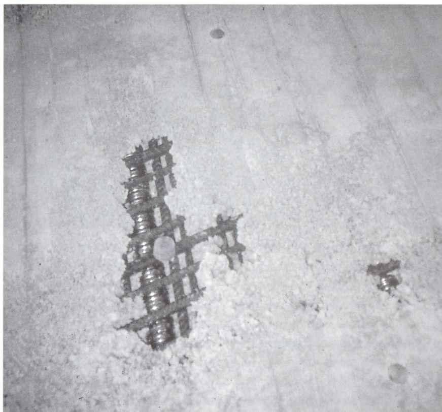
Ces gros dégâts sur la face inférieure d'un pont sont dus à un trop petit espacement des fers d'armature et à un recouvrement insuffisant.
