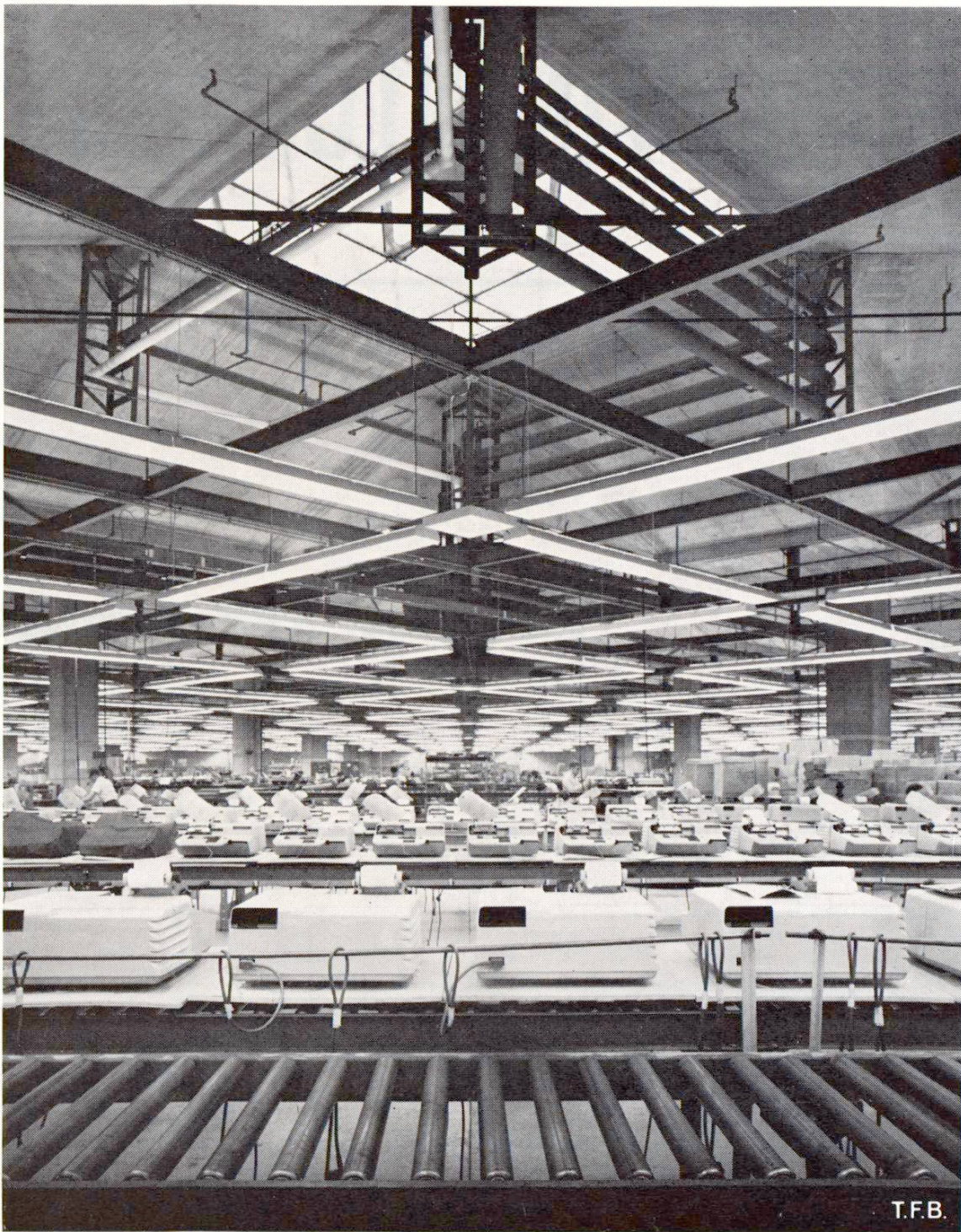
Fig. 1 Le grand local de fabrication recouvert d'«entonnoirs» octogonaux de 18,30 \times 18,30 m. Eclairage naturel d'en haut par panneaux synthétiques. L'éclairage artificiel et toutes les installations visibles sont suspendus à la toiture en béton. Les canalisations circulent le long des diagonales du réseau carré des appuis.
