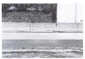
Fig. 8 Bord du béton parfaitement vertical juste après le passage de la deuxième finisseuse à coffrage glissant.
