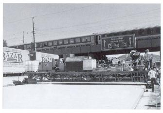
Fig. 7 La finisseuse à coffrage glissant peut franchir facilement même les passages étroits.
