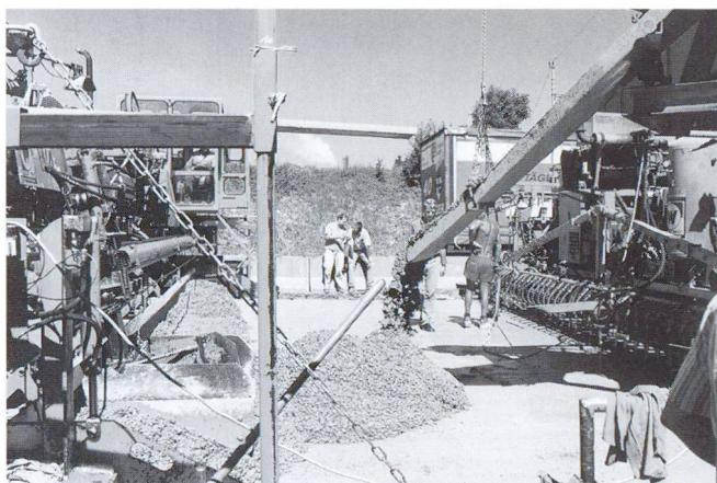
Fig. 4 Le béton pour la finisseuse à coffrage glissant de la couche supérieure (à gauche) est amené par une bande transporteuse montée au-dessus de la finisseuse pour la couche inférieure.
