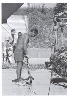
Fig. 2 Introduction par vibration d'un fer de liaison dans le joint longitudinal médian, sous le regard intéressé des Suisses.
