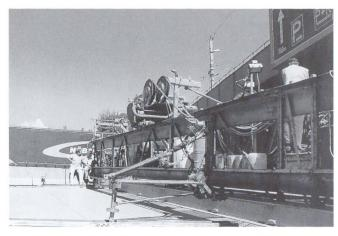
Fig. 5 La planéité du béton supérieur est optimalisée au moyen du lisseur longitudinal de la deuxième finisseuse à coffrage glissant.
