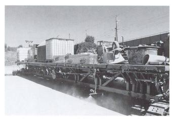
Fig. 6 Application du retardateur par aspersion à la fin de la mise en place de la chaussée en béton en deux couches.
