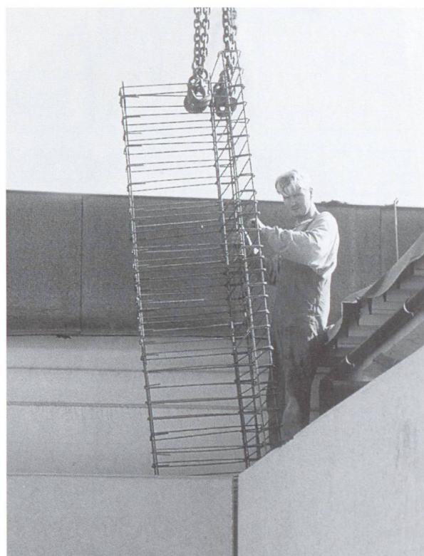
Fig. 9 Pose du panier d'armature aux angles des prémurs.
