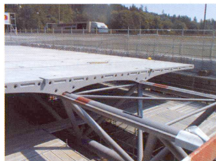
Fig. 1 Les éléments en béton préfabriqués ont d'abord été déposés sur la charpente métallique.
