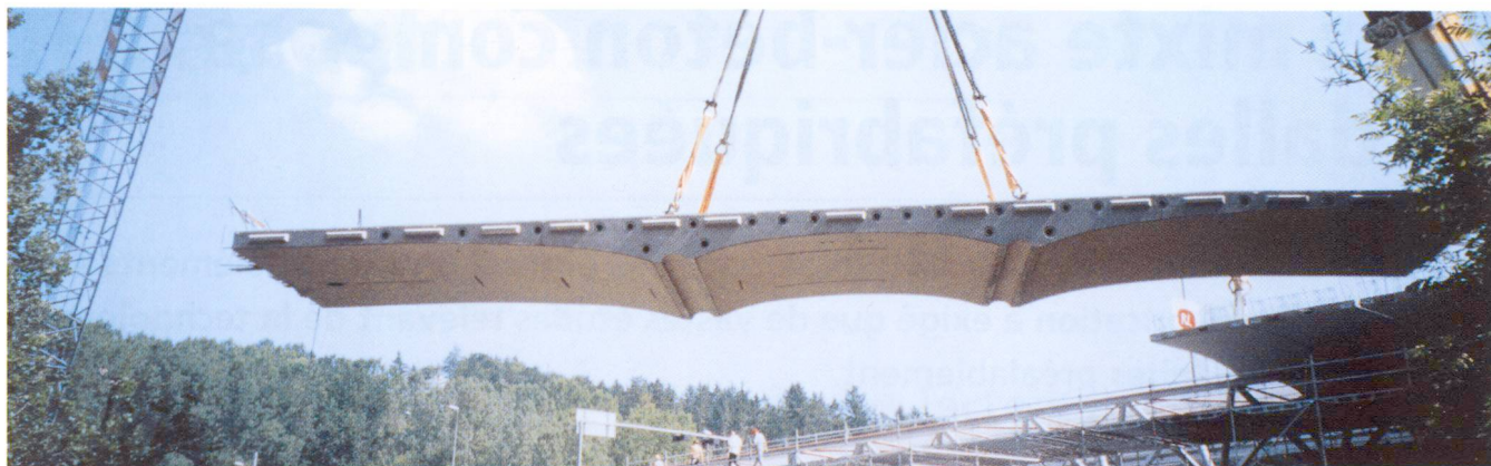
Fig. 2 Une des 61 dalles préfabriquées du nouveau viaduc de la A1 à Dättwil est mise en place au moyen de la plus grande autogreue sur chenilles de Suisse. Ces dalles ont 15,90 m de longueur, 3,20 m de largeur, et aux endroits les plus minces, 0,25 m d'épaisseur.
