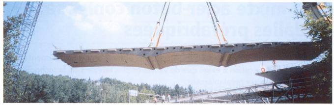
Fig. 2 Une des 61 dalles préfabriquées du nouveau viaduc de la A1 à Dättwil est mise en place au moyen de la plus grande autogrue sur chenilles de Suisse. Ces dalles ont 15,90 m de longueur, 3,20 m de largeur, et aux endroits les plus minces, 0,25 m d'épaisseur.
