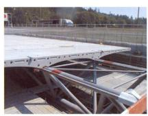
Fig. 1 Les éléments en béton préfabriqués ont d'abord été déposés sur la charpente métallique.
