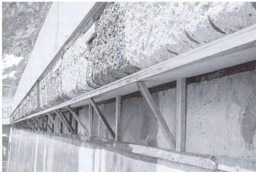
Console du parapet d'un couronnement de mur de barrage prête pour la projection (ancien béton piqué et coffré).
