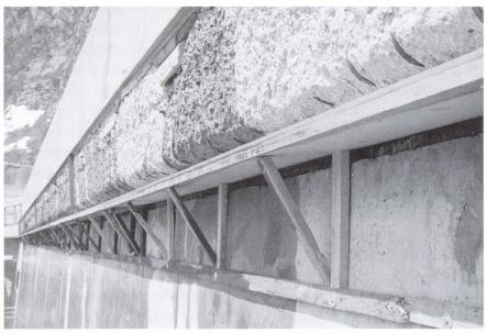
Console du parapet d'un couronnement de mur de barrage prête pour la projection (ancien béton piqué et coffré).
