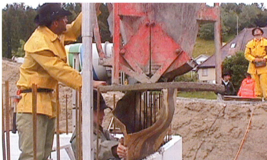
Bétonnage d'un pan de mur avec du béton autocompactant (SCC).
