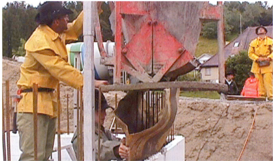
Bétonnage d'un pan de mur avec du béton autocompactant (SCC).
