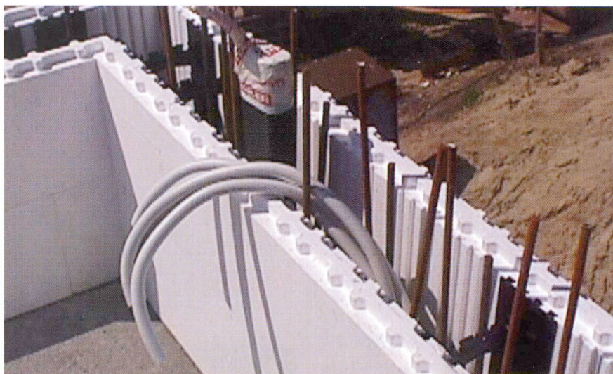
Des tuyaux vides peuvent également être logés dans les murs pour les installations domestiques.
