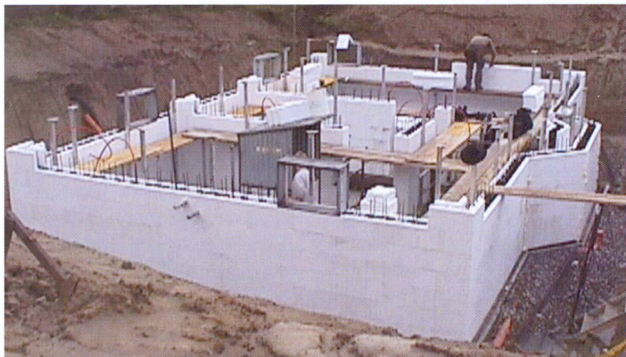
Mise en place du coffrage pour l'étage en sous-sol.
