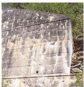
Fig. 2 Superposition de fissures dues à la RAG, à la corrosion et à des contraintes statiques, avec dépôts calcaires.
