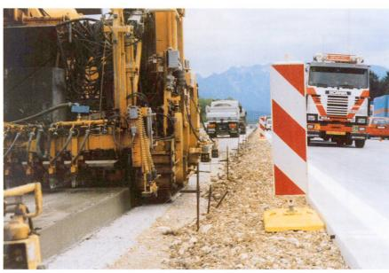
Fig. 3 Les chaussées en béton modernes sont mises en place avec des finisseuses à coffrage glissant.
