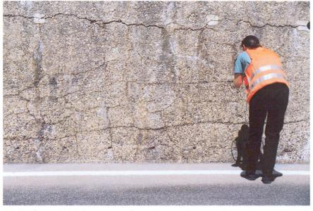
Dégâts dus aux RAG dans un mur de soutènement non armé.
