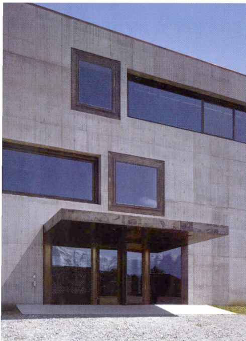
Façade d'entrée de l'école de Paspels.
