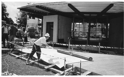
Recouvrement avec des nattes thermo-isolantes d'un revêtement en béton fraîchement mis en place.
