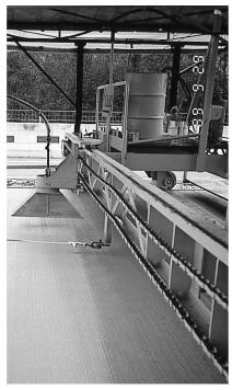
Traitement avec un produit de cure directement après la mise en place du béton avec une finisseuse. Photo: archives TFB
