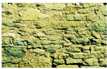
L'ancienne maçonnerie apparaît derrière l'enduit qui se détache: mur de maison à Lenzbourg. Photos: Kurt Hermann
