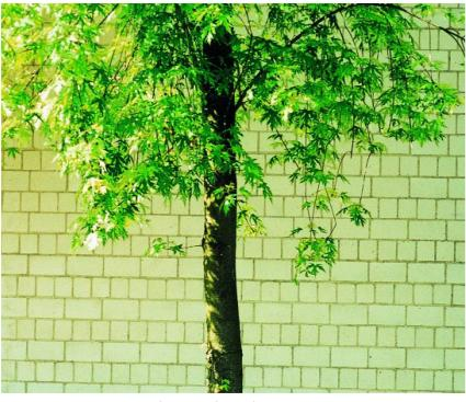
Maçonnerie apparente en briques silico-calcaires.
