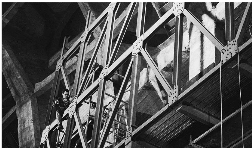
Fig. 4 Montage de la structure porteuse.
