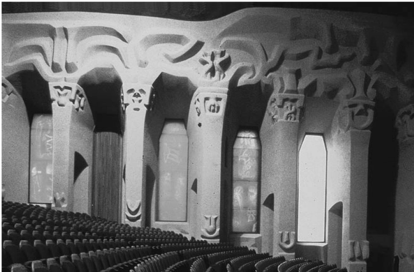
Fig. 12 Mur nord de la grande salle. Les fenêtres en verre poli datent des années trente.
