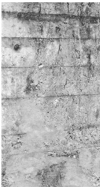
Restitution d'eau provenant d'un nid de gravier.
