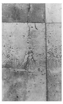
Restitution d'eau dans la zone d'un joint de bétonnage. Photo: archives TF
