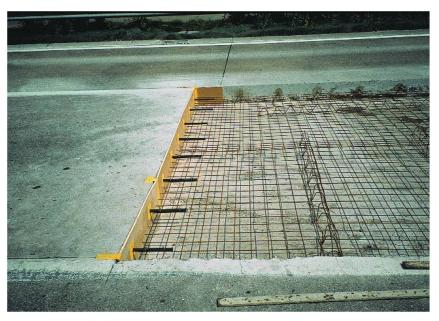
Remplacement de dalles: préparé pour le bétonnage.
