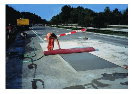
Traitement de cure: recouvrement de l'endroit réparé, aspergé avec un produit de cure.
