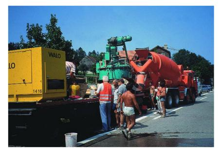
Préparation de béton à haute résistance initiale au lieu d'utilisation.
