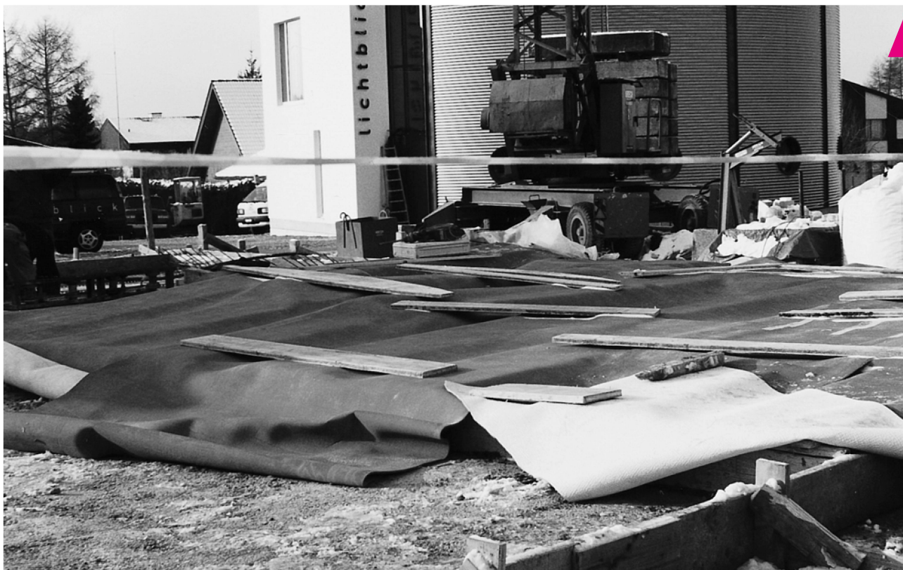
Dalle de fond fraîchement bétonnée protégée contre le froid et les courants d'air.
