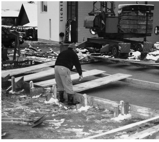
Préparation de l'isolation d'une dalle de fond fraîchement bétonnée.
