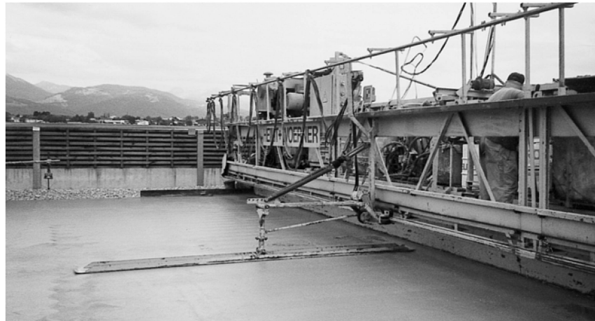
Talocheuse longitudinale en action.
