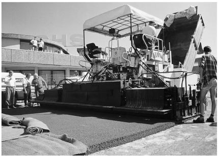
Mise en place de béton drainant.
