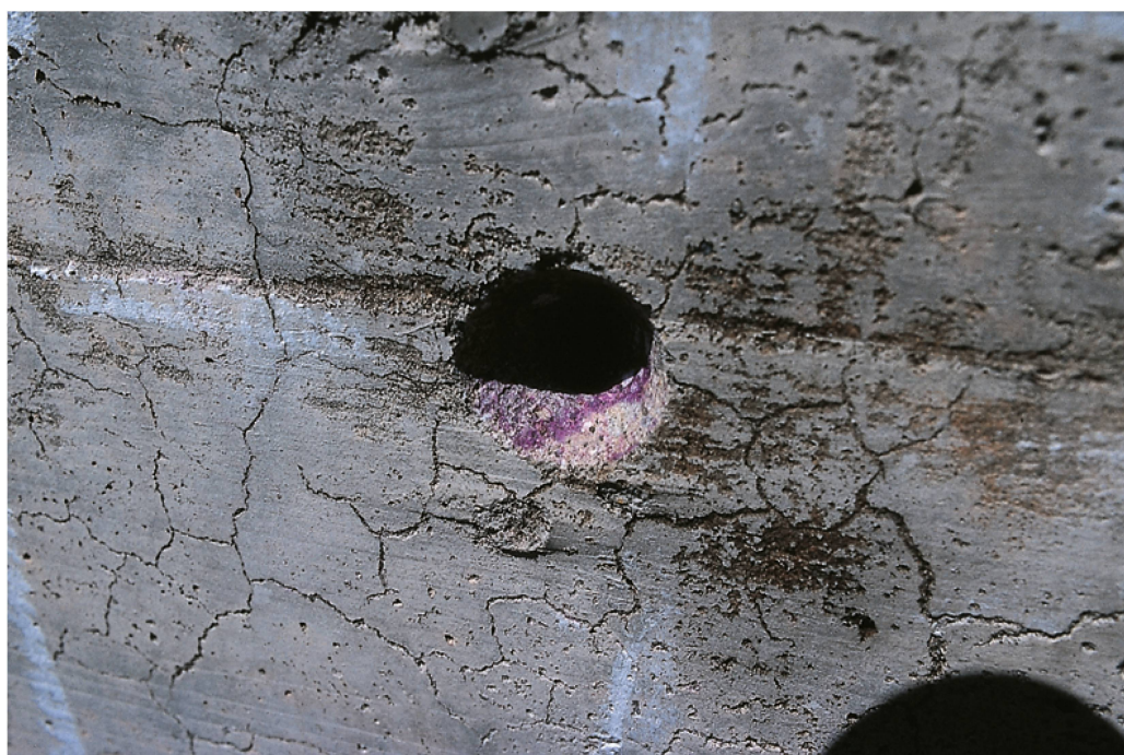
Cause des fissures: traitement de cure insuffisant.
