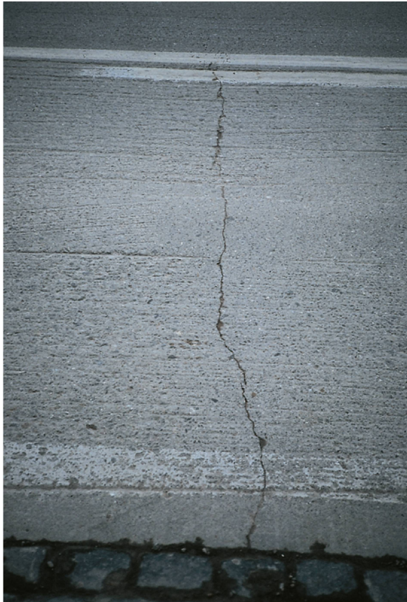
Fissure traversante sur une route en béton ayant plus de 50 ans.
