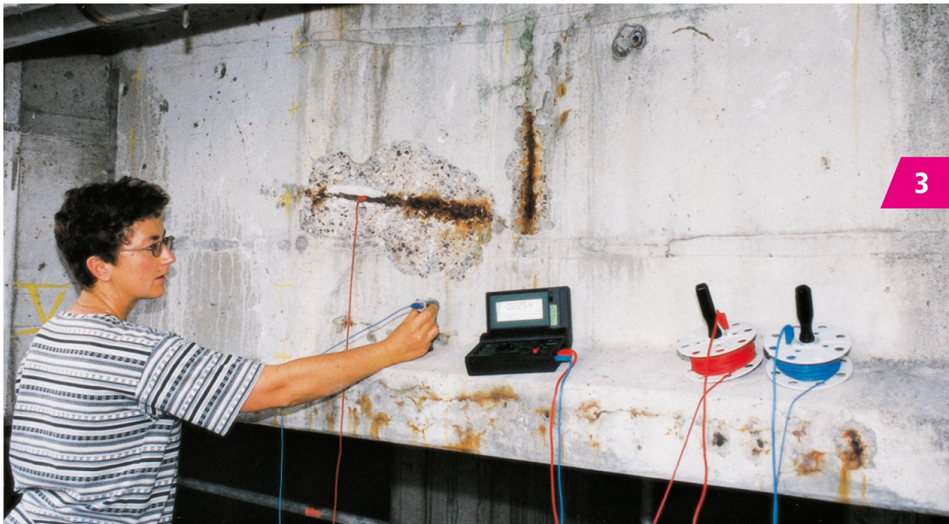
Mesure de potentiel sur la face inférieure d'un pont.
