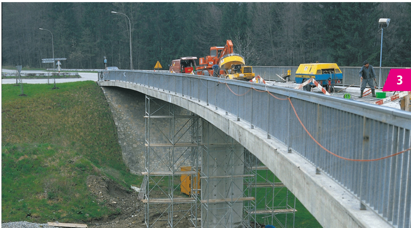
Réfection d'un pont en béton.
