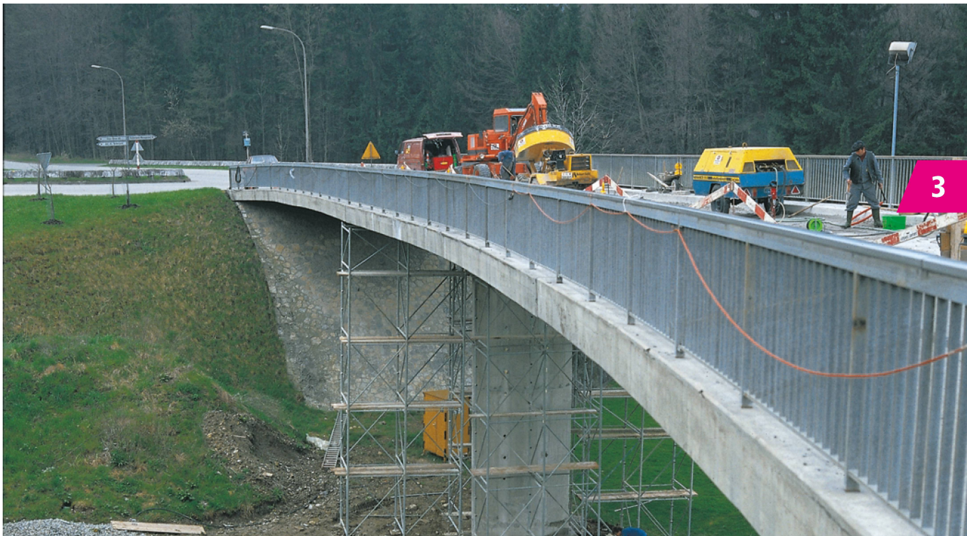
Réfection d'un pont en béton.
