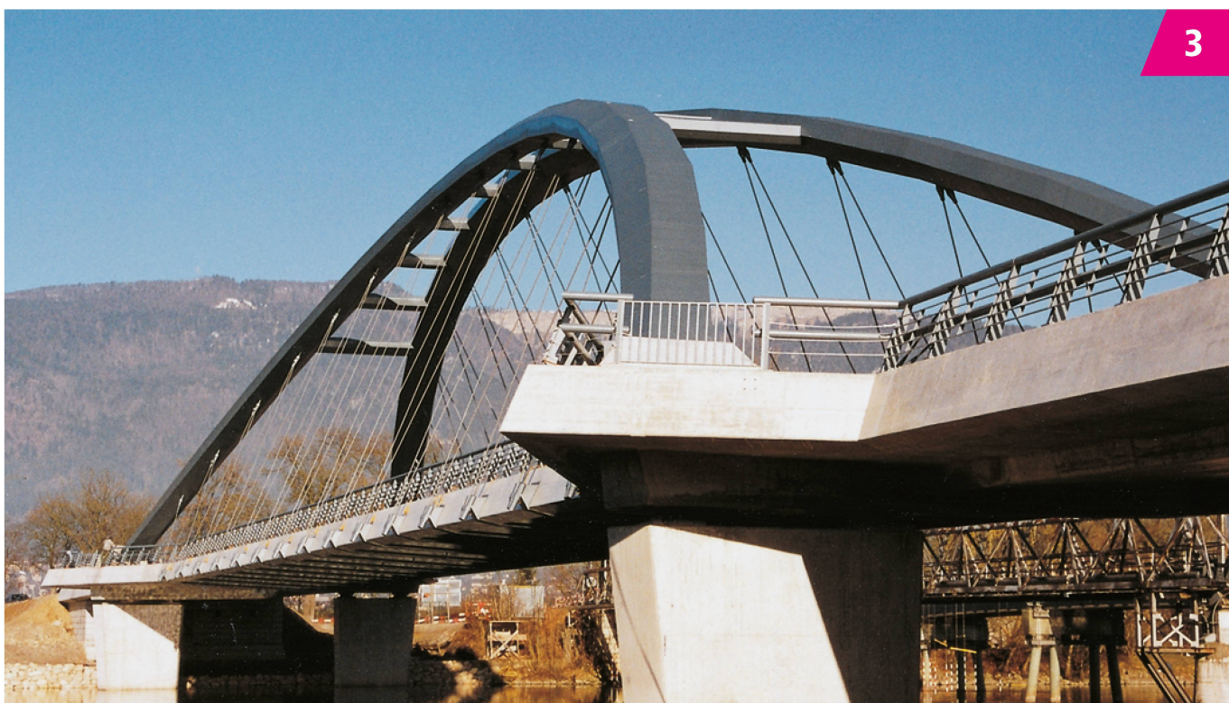
Pont sur l'Aar près d'Arch (A 5).
