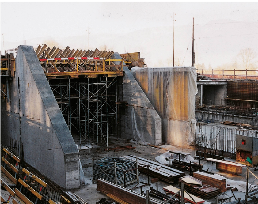
Tunnel à ciel ouvert de Lüsslingen (A 5): utilisation de CEM II/A-L 32,5 R.
