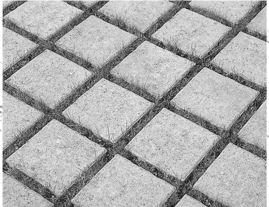
Pavage perméable à l'eau avec joints engazonnés.
