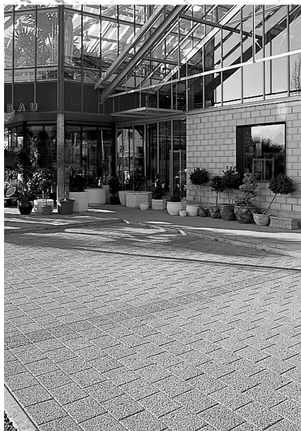
Pavés filtrants perméables à l'eau et à l'air en zone à faible circulation.
