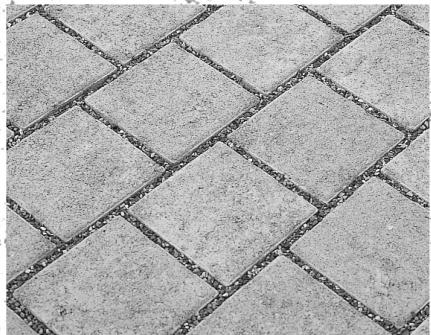
Pavage perméable à l'eau avec joints gravillonnés.
