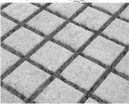
Pavage perméable à l'eau avec joints engazonnés.
