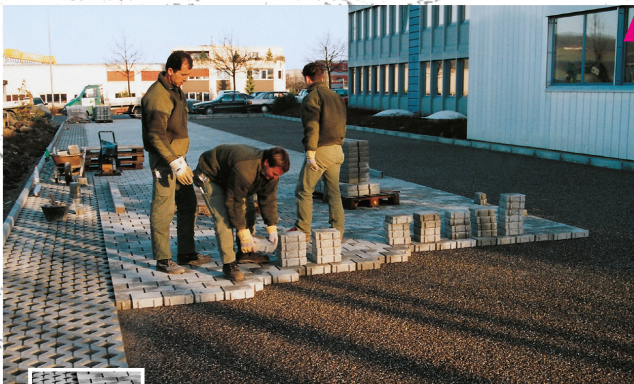
Pose manuelle de pavés en béton.
