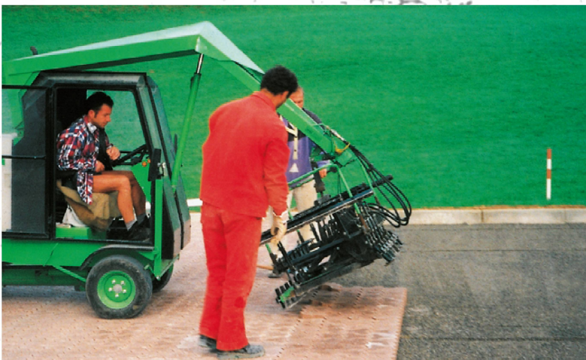
Des machines de pose permettent de poser les pavés en béton directement depuis la palette.
