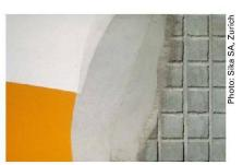
Enduit de protection faisant partie d'un reprofilage: barbotine d'accrochage, mortier de reprofilage, mortier d'égalisation et enduit.
