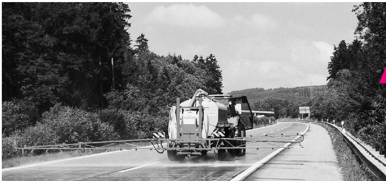
Imprégnation hydrophobe d'une chaussée en béton.
