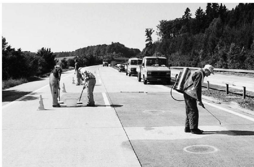
Essais préalables sur une chaussée en béton pour le traitement par imprégnation hydrophobe: application du produit d'imprégnation au pistolet ou au rouleau.
