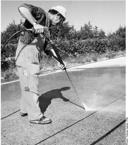
Nettoyage au jet d'eau haute pression (200 bars) d'une surface-test pour l'application d'une imprégnation hydrophobe sur une route en béton datant de 16 ans.
