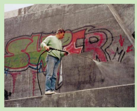
Elimination de graffiti sur du béton apparent prétraité avec une imprégnation et une couche de cire (couche sacrificielle).
