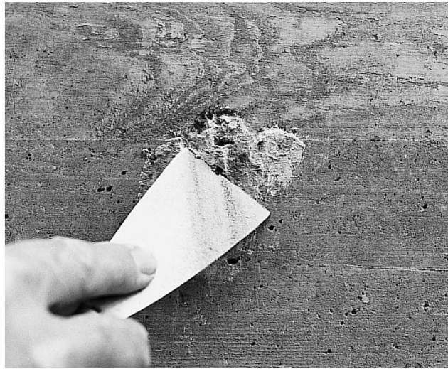
Fig. 6 La pâte adsorbante sèche est éliminée.
