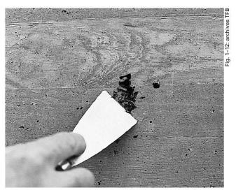
Fig. 2 On élimine un maximum de matière souillante avec la spatule.
