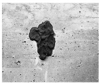
Fig. 8 On applique encore une fois de la pâte adsorbante.
