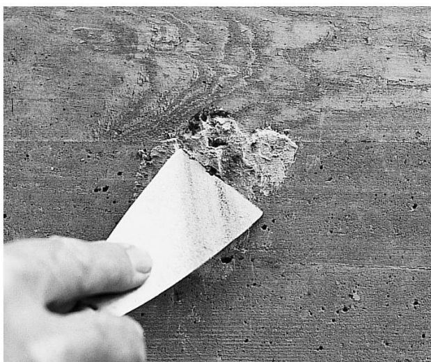
Fig. 6 La pâte adsorbante sèche est éliminée.
