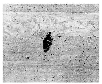
Fig.1 Surface de béton souillée par du bitume.
