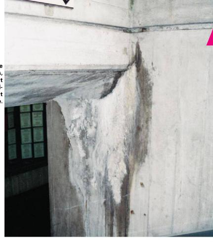
n'est efficace que lorsque les souillures touchent uniquement la surface du béton, ou y sont fixées par des composés solubles à l'eau, tel le gypse (CaSO<sub>4</sub> · 2 H<sub>2</sub>O). (Le gypse résulte de la réaction de l'hydroxyde de calcium [Ca(OH)<sub>2</sub>] issu de l'eau contenue dans les pores du béton avec le dioxyde de sulfure [SO<sub>2</sub>] contenu dans l'air.)
