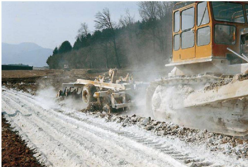
Incorporation de chaux vive avec une herse à disques.
