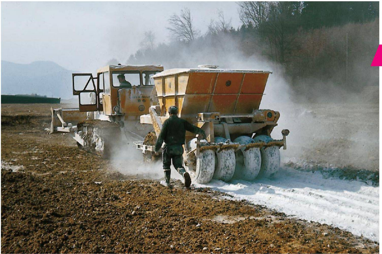
Epandage de chaux vive sur la plate-forme.
