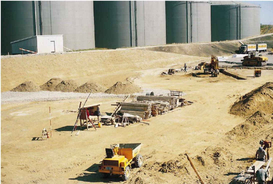
Construction d'un bassin de rétention stabilisé à la chaux pour le stockage d'hydrocarbures.
