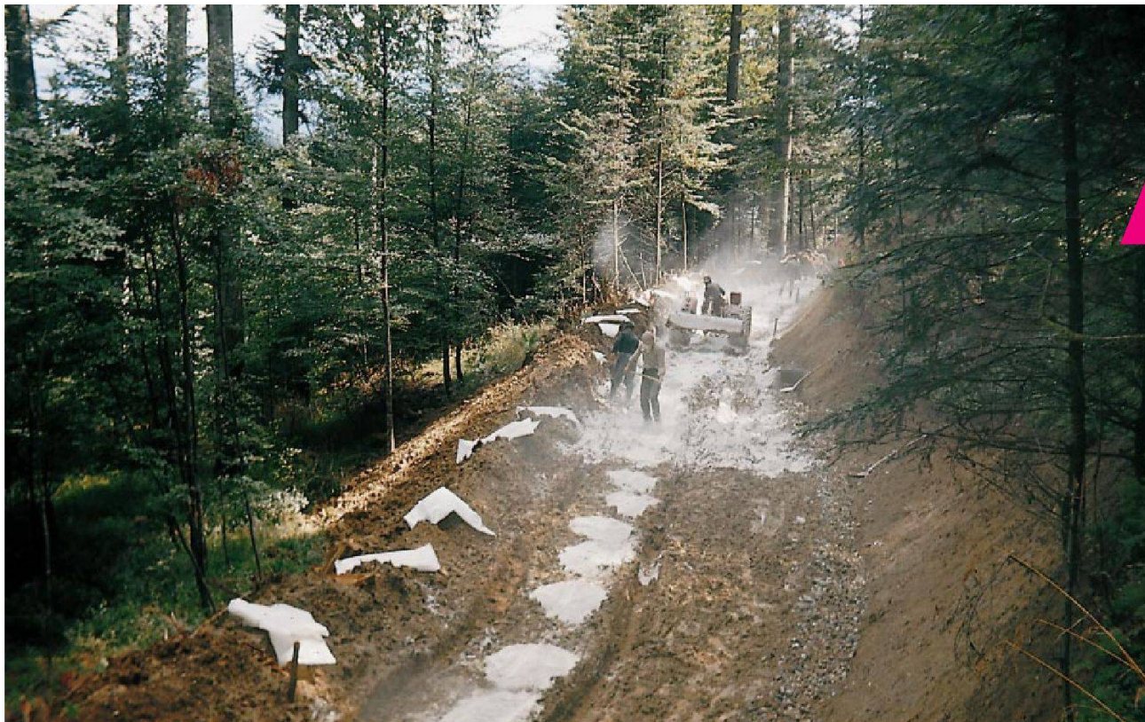
Stabilisation à la chaux dans la construction de chemins forestiers.
