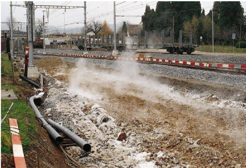
L'eau s'évapore après le malaxage de la chaux vive (réaction à court terme).
