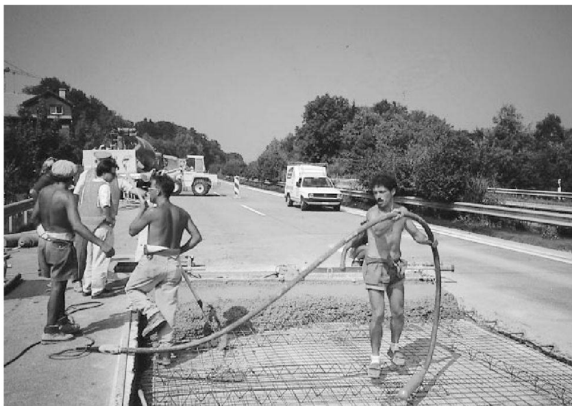
Remplacement partiel d'une dalle en béton (A1).
