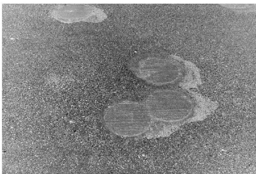
Dégradations de surface réparées (forages de 300 mm de diamètre) sur la A8.
