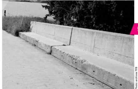
Dégâts dus aux sels de déverglaçage (éclatements) sur un parapet de pont.
