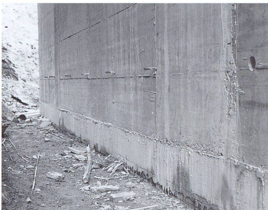
Partie de mur en béton lourd (à l'arrière) et béton ordinaire (bloc de radio-protection pour deux accélérateurs linéaires à l'hôpital cantonal de Lucerne).
