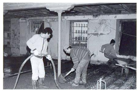
Rénovation d'un ancien bâtiment au moyen du système mixte bois-béton (béton léger BL 20/10, masse volumique 1,5 kg/m³).
