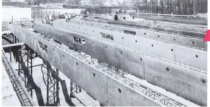
Solives préfabriquées d'environ 24 m de longueur, en BL 35/25 d'une masse volumique de 1,8 kg/m<sup>3</sup>.
