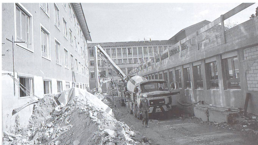
Photo: Werner Hauser, Betonpumpen AG, Zürcher Unterland, Dällikon
