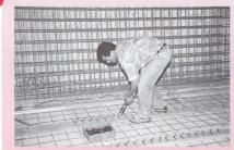
Disposition par paire sur une rangée des éléments de liaison lors d'une transformation.
