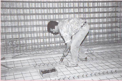
Disposition par paire sur une rangée des éléments de liaison lors d'une transformation.
