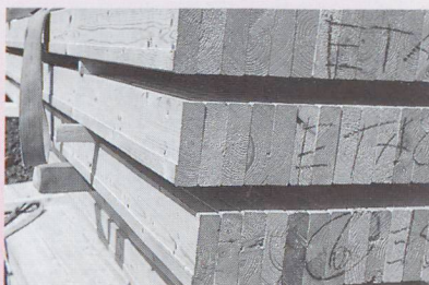
Eléments en planches clouées juxtaposées avec détail du joint des éléments.
