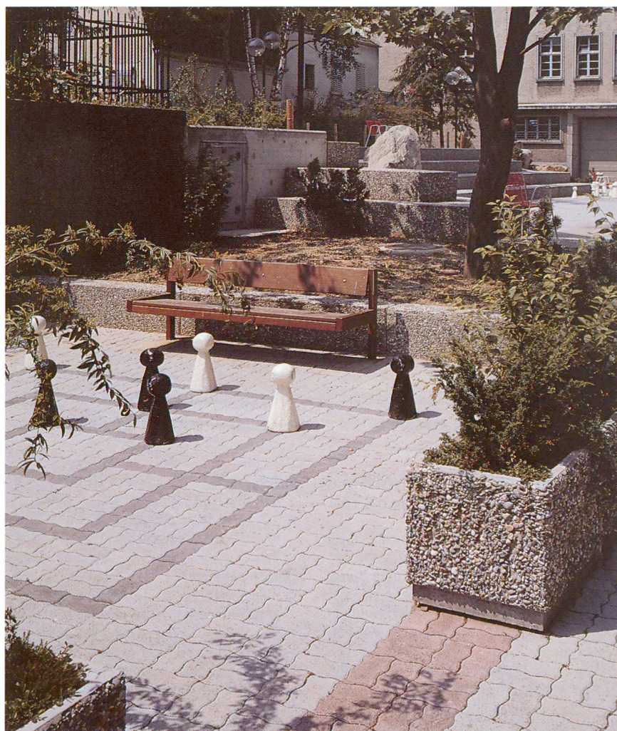
Pavés à emboîtement sur une place de jeux.
