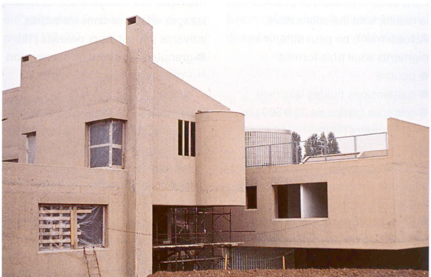
Béton coloré dans la masse coulé sur place et sablé (Italie).
