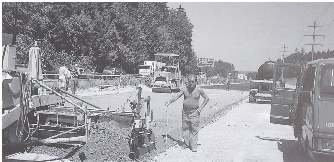
Le CEM II/A-L convient bien pour la stabilisation des sols.
