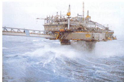
Des bétons à hautes performances contenant de la fumée de silice confèrent stabilité et durabilité à des plates-formes de forage en mer du Nord.
