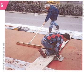
Une utilisation intéressante des ajouts du béton: revêtements en béton teinté aux arrêts de bus.
