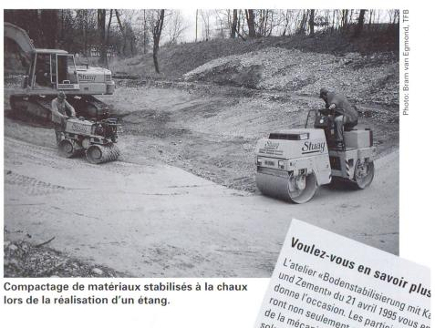
Compactage de matériaux stabilisés à la chaux lors de la réalisation d'un étang.
