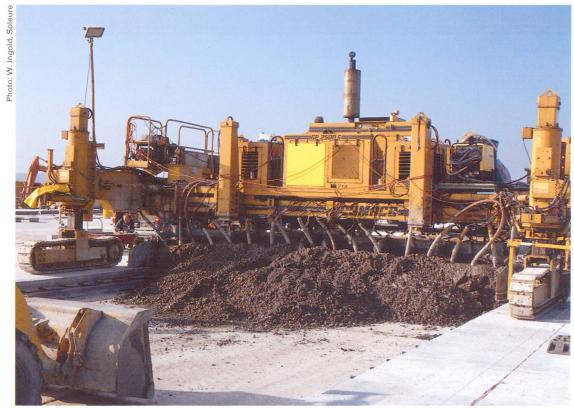
Mise en place avec finisseuse sur rails.
