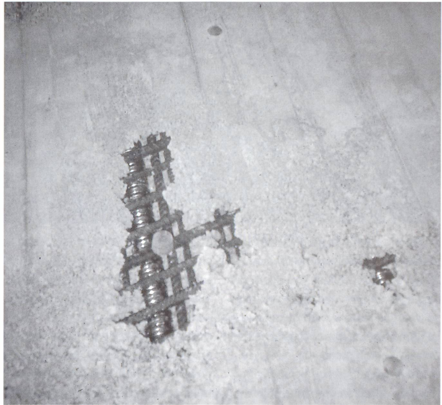
Ces gros dégâts sur la face inférieure d'un pont sont dus à un trop petit espacement des fers d'armature et à un recouvrement insuffisant.
