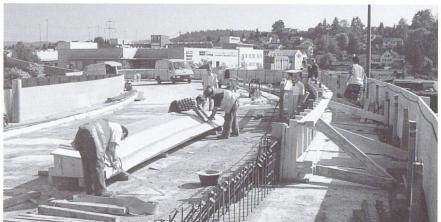
Lés de coffrage dissipant l'eau tendus sur des éléments de parapet.
