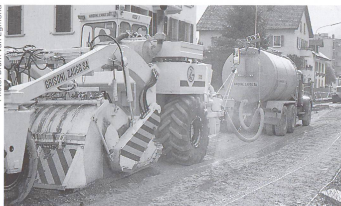
Recyclage à froid avec la Ra-Co 250. Le réservoir raccordé au moyen d'un flexible fournit l'eau pulvérisée.
