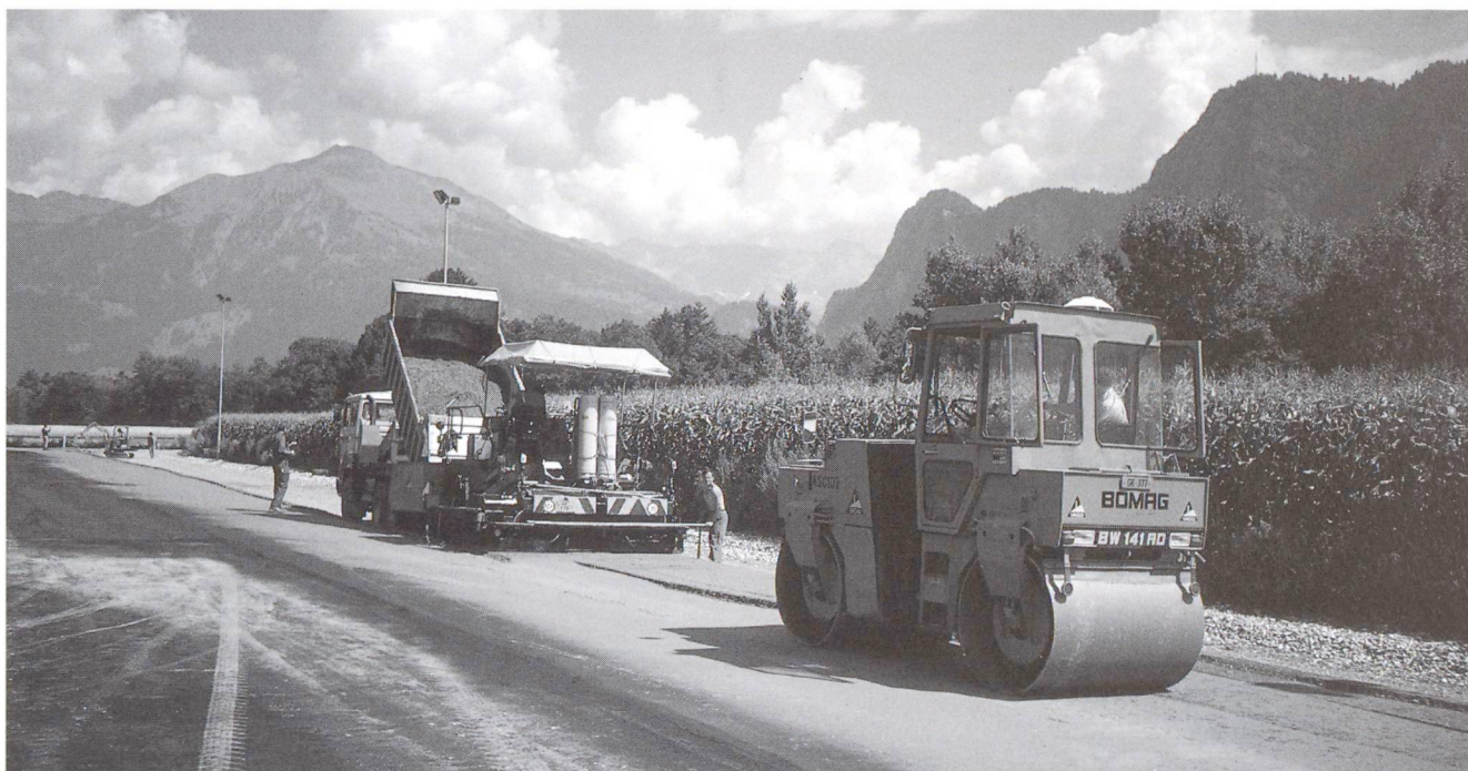
Mise en place à la finisseuse, suivie du compactage avec un rouleau vibrant.
