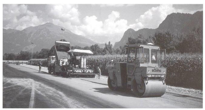
Mise en place à la finisseuse, suivie du compactage avec un rouleau vibrant.
