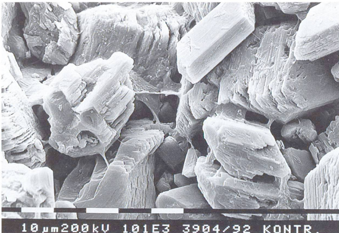
Pâte de ciment durcie corrodée avec cristaux de gypse; agrandissement environ 1000 fois.
