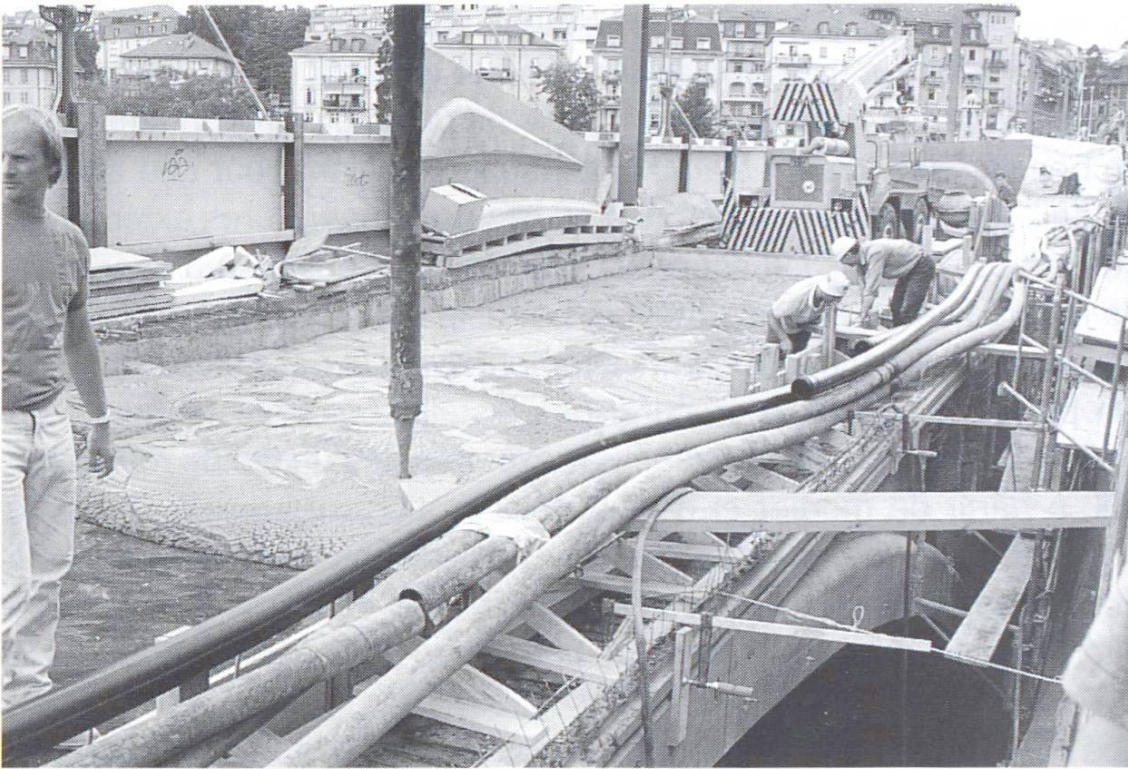
Remplissage de vides sous le futur tablier d'un pont de Lausanne.
